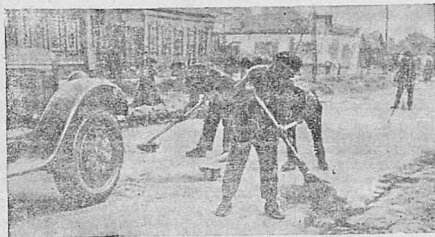
Подготовка дороги для укладки асфальта на строительстве московского наука (Рязанское шоссе)
